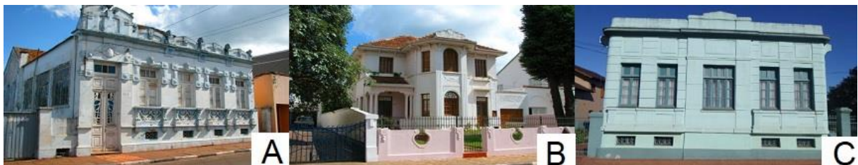
Figura 02: Edificações integrantes da lista de interesse cultural
