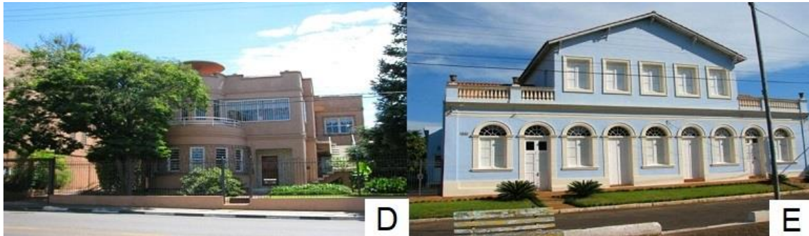
Figura 03: Edificações integrantes da lista de interesse cultural
